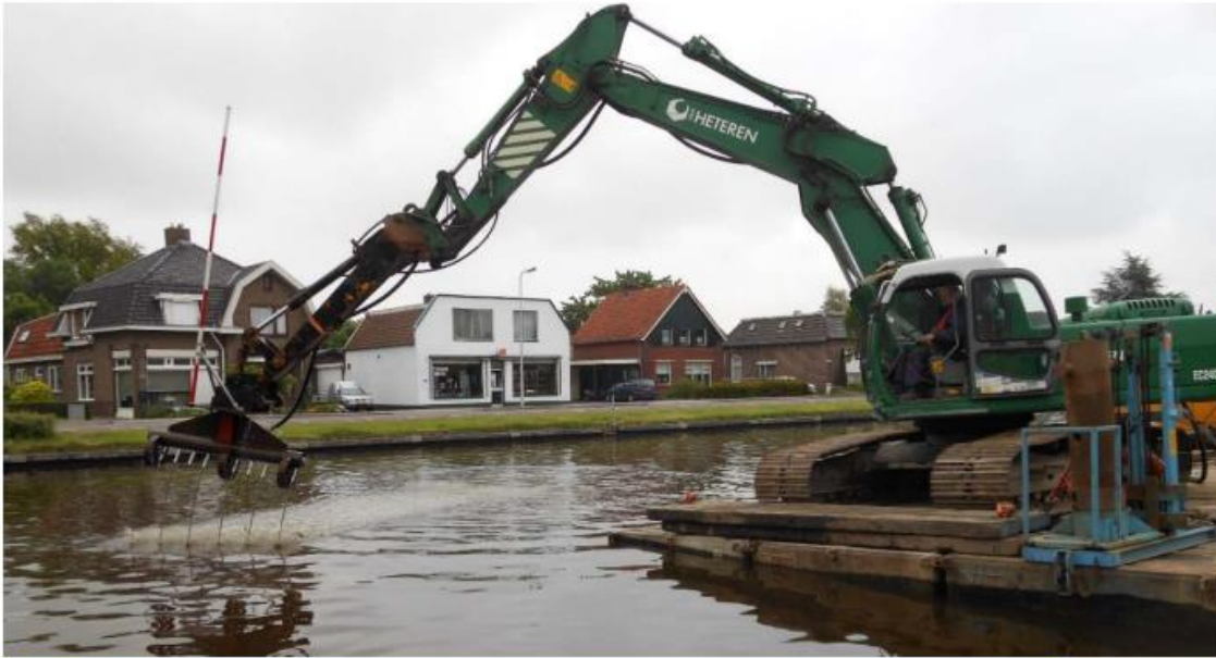
Figuur 3.8 Het aanbrengen een zand-bentonietmengsel door Van Heteren (bron : Van Heteren)
